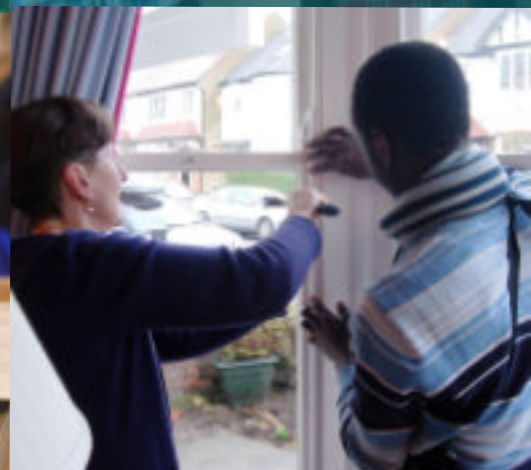
Уплътняване на дограми на прозорци Брикстън, Лондон, Великобритания
